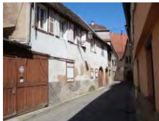
Rue des Serruriers = R+1+combles, soit 5 à 6 mètres à l'égout
