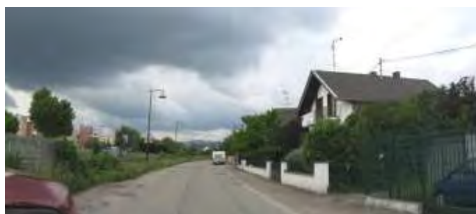
Vue depuis la rue de la Fonderie : un espace non valorisé en bordure de la voie ferrée
