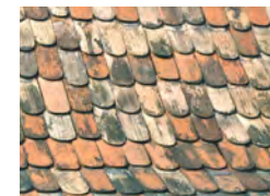
Couverture à simple recouvrement
