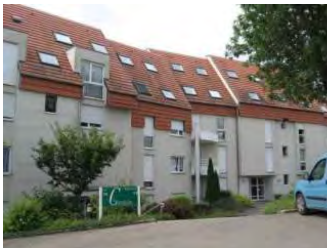
Collectifs récents, en "corniche" rue des Rochers, à l'Ouest de la ville
