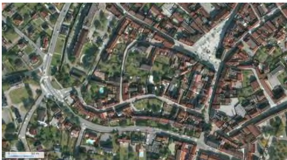
Vue aérienne à laquelle se superpose le cadastre (source : IGN Géoportail, site internet)
