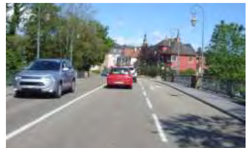
Avenue de la Gare, vue du pont de la Bruche, aujourd'hui
