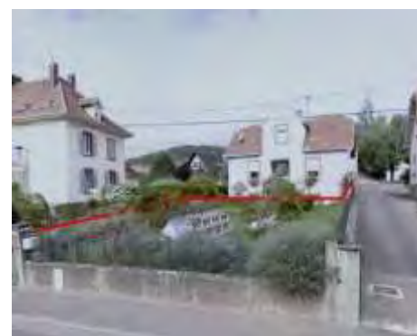
Rupture de l'alignement et réduction de la densité : rue du Général De Gaulle
