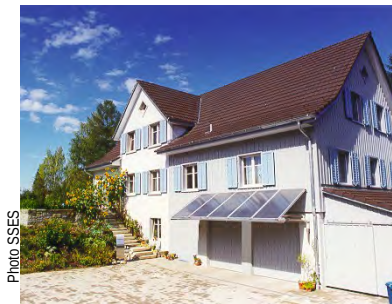
Capteurs posés dans le plan de la toiture d'une véranda ou servant d'auvent
