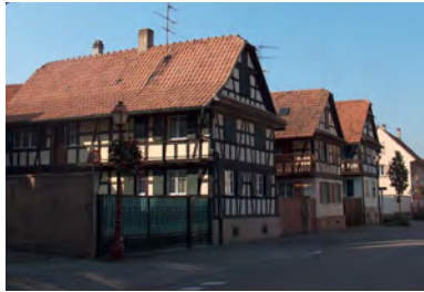
Toiture 2 pans, avec ou sans demie-croupe. ligne de faîtage perpendiculaire à la rue. Plus rarement avec deux vraies croupes.
