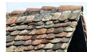
Couverture à double recouvrement
