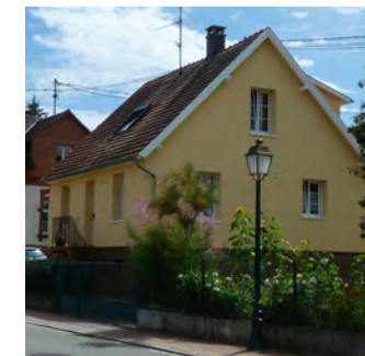
Après travaux d'isolation
