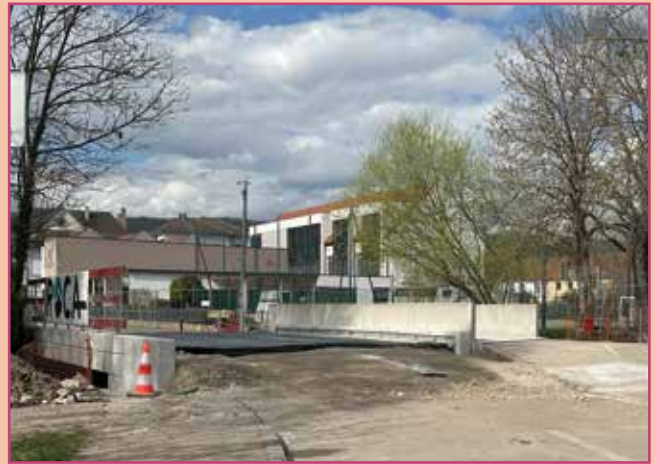
Le tablier du pont Mistler a été installé le lundi 3 mars. Il s'agira maintenant pour Eiffage Route de réaliser les enrobés et de reprendre les pistes cyclables et les trottoirs pour lisser la pente induite par le surélévement du pont.
