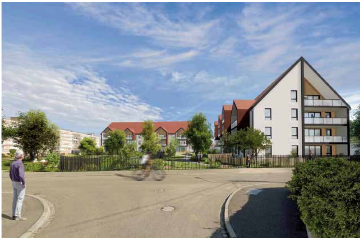
La rue du Général Kopp débouchera sur la nouvelle Résidence seniors à la fin du 2 e semestre 2026 - visuel non contractuel - © Bik architecture Grand Est.
