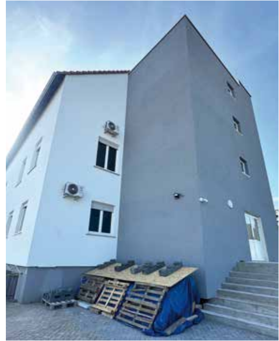
La construction de l'ascenseur pour desservir les étages a été l'élément le plus impactant de l'enveloppe budgétaire.
