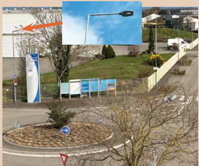
Eclantec, VHM éclairage, Ragni et Rohl sont les quatre marques de luminaires qui équiperont les mâts d'éclairage de la Ville.
