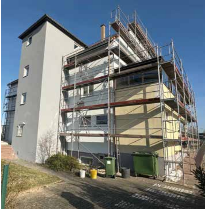
Construit en 2000, le bâtiment a été entièrement réaménagé, à l'intérieur comme à l'extérieur pour répondre aux normes.
