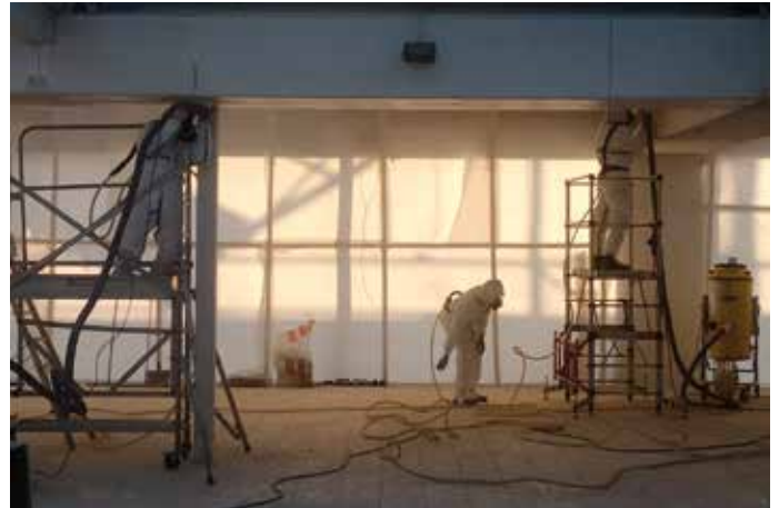
Avant de démolir le bâtiment il a fallu procéder à son déplombage et à son désamiantage. Cette opération a été confiée à une entreprise spécialisée.
