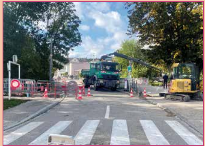
Les travaux de dévoiement de la conduite de gaz qui traversait la chaussée ont été réalisés en octobre.
