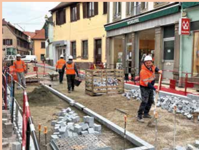
Les travaux de la phase 4 devraient se terminer avant Pâques.
