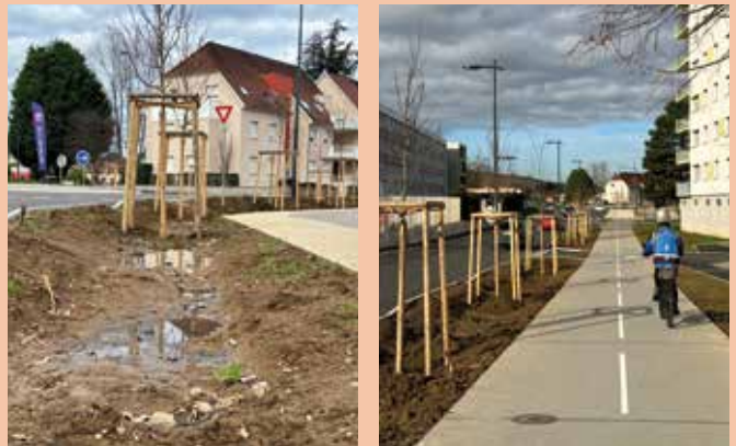
Réalisation de noues d'infiltration et plantation d'arbres confèrent une plus-value environnementale indéniable au quartier.
