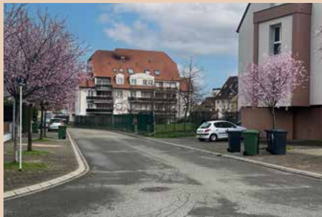
La Ville a prévu d'aménager des places de stationnement avec des pavés perméables et de retravailler la forme de la chaussée pour avoir une pente naturelle et ainsi assurer l'écoulement des eaux pluviales.
