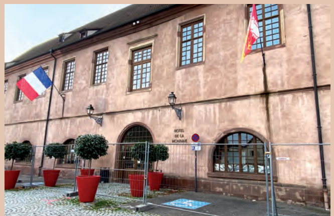
L'accès à l'Hôtel de la Monnaie est interdit au public.
