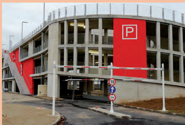
Le parking silo sera "a priori" opérationnel avant Noël. Son accès est totalement gratuit.
