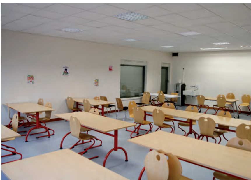
La seconde salle de restauration qui servait auparavant d'espace périscolaire au rez-de-chaussée de la Maison des élèves a également été repeinte avec la nouvelle gamme de peintures écologiques.
