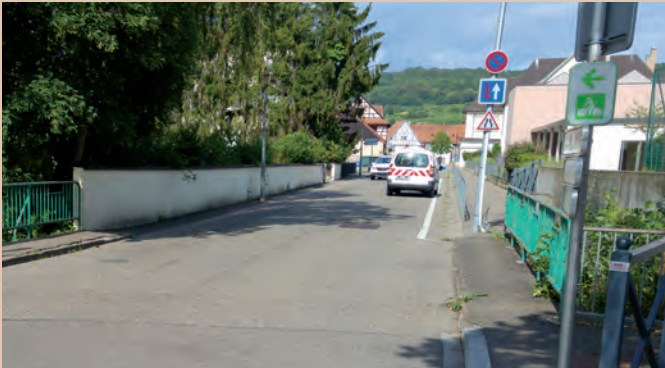
Afin de garantir la sécurité des usagers, des travaux d'aménagement de la structure du pont situé rue Charles Mistler sont programmés en 2021.
