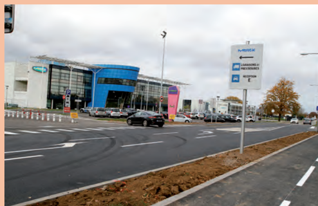
La voirie a été élargie à 10 m et une zone 30 a été instaurée au niveau du tronçon nouvellement aménagé.
