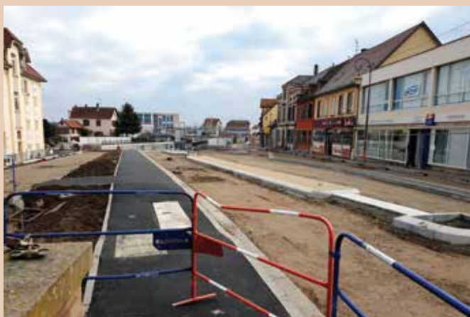
Côté avenue de la gare, place aux futurs trottoirs dont les enrobés ont été posés mi-décembre (Photos Passion photo Club).
