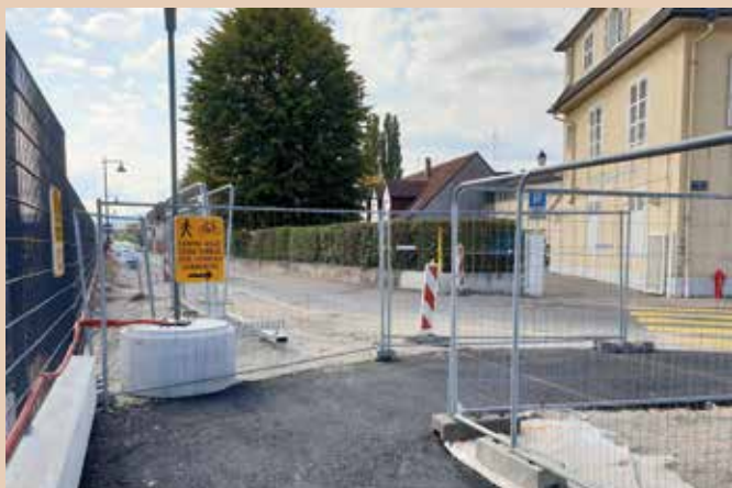
Afin de permettre au Conseil départemental du Bas-Rhin de démarrer les travaux de voirie, le circuit piétonnier et cycliste, gare-centre-ville, a été déplacé début octobre.
