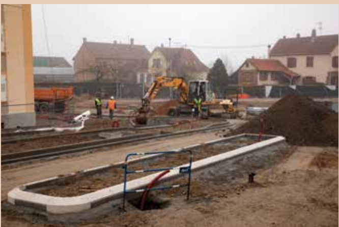
Les ouvriers ont travaillé sans relâche pour mettre en place les bordures et les îlots destinés à séparer les sens de circulation.
