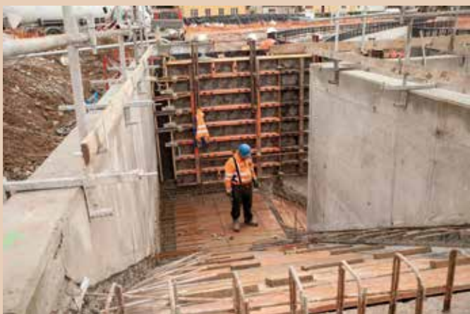
Place au ferrailage du futur escalier permettant à terme aux piétons et aux cyclistes de regagner le parvis de la gare.
