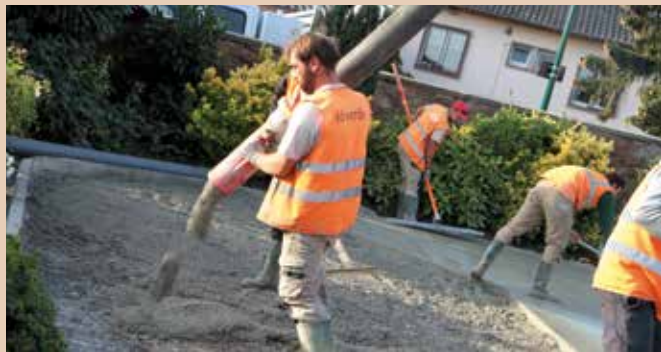
Une bonne dizaine de toupies à béton d'une capacité de 8 m 3 chacune a été nécessaire pour bétonner l'allée principale et la placette.
