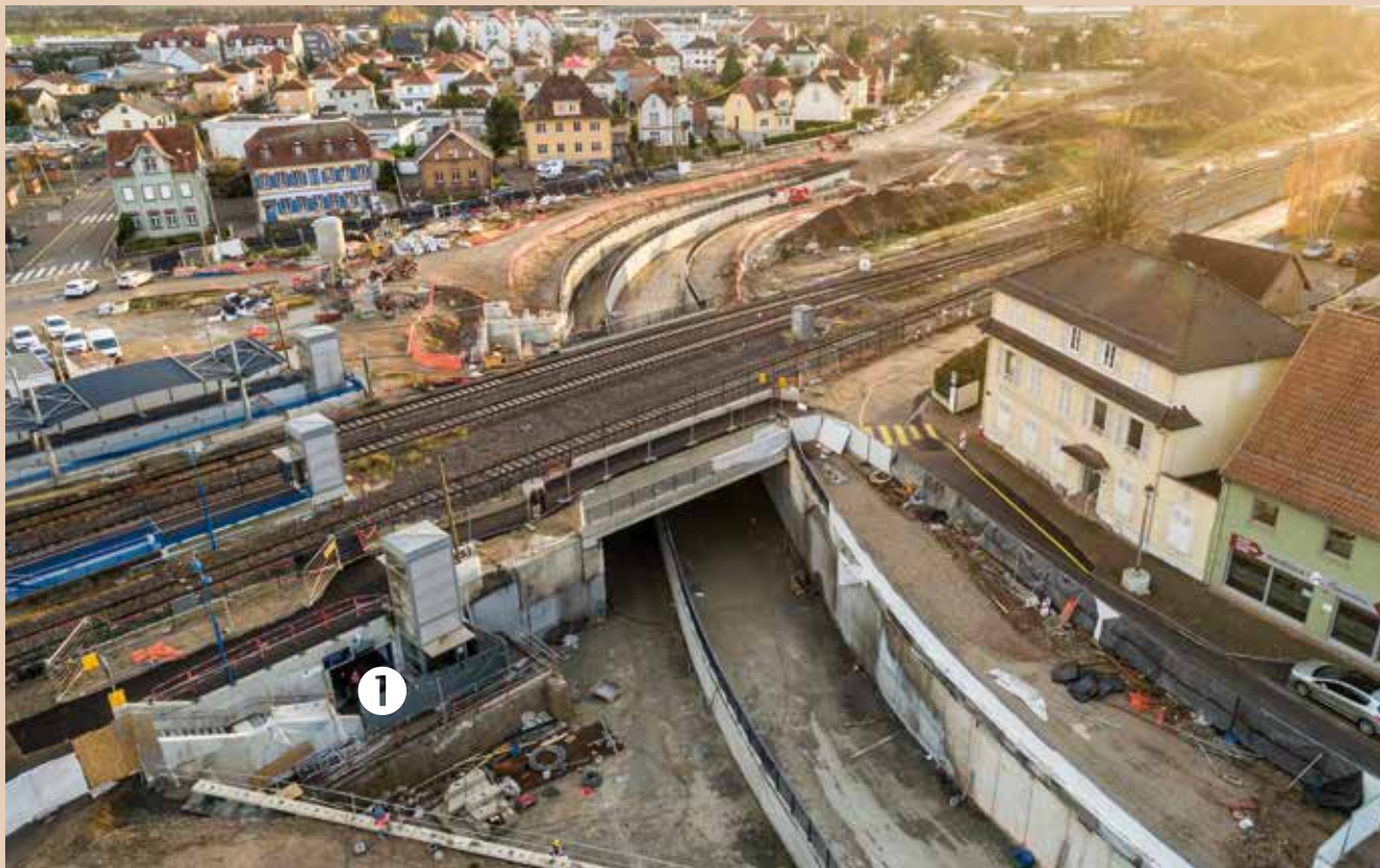
Cette photo prise par drone au début du mois de décembre donne un aperçu global de l'évolution du chantier. On remarque notamment que les garde-corps ont bien été posés et on distingue parfaitement que le mur d'accès au passage souterrain a été percé ❶ (Photo Drone Sessions).
