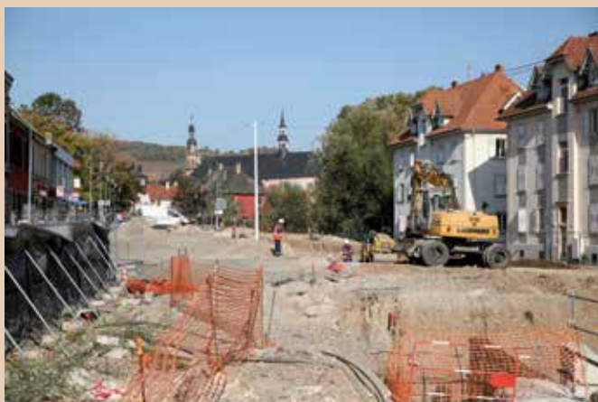
Début octobre, le Département a démarré les travaux de voirie permettant de rouvrir l'axe reliant l'avenue de la Gare à la route de Dachstein.
