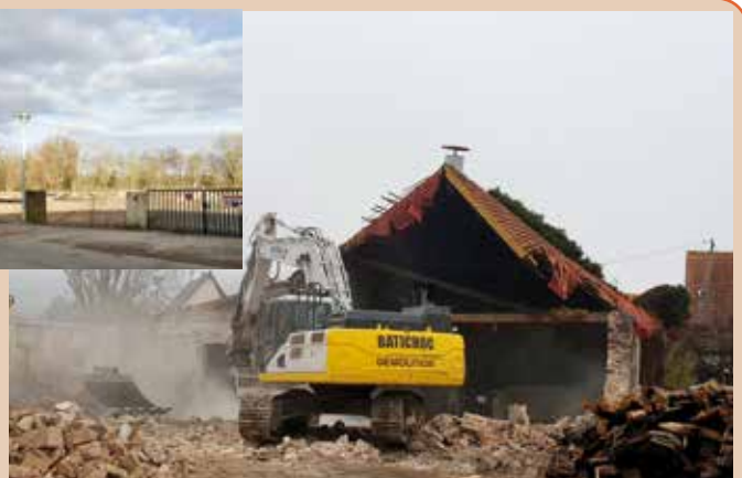
Avant la démolition des écuries, l'entreprise Batichoc a procédé à la dépose soignée des tuiles et à leur entreposage dans des casiers.
