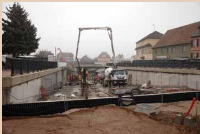
Durant cet automne, SNCF Réseau a finalisé les travaux de pose des revêtements définitifs. Les garde-corps ont également été installés de part et d'autre du futur passage souterrain.
