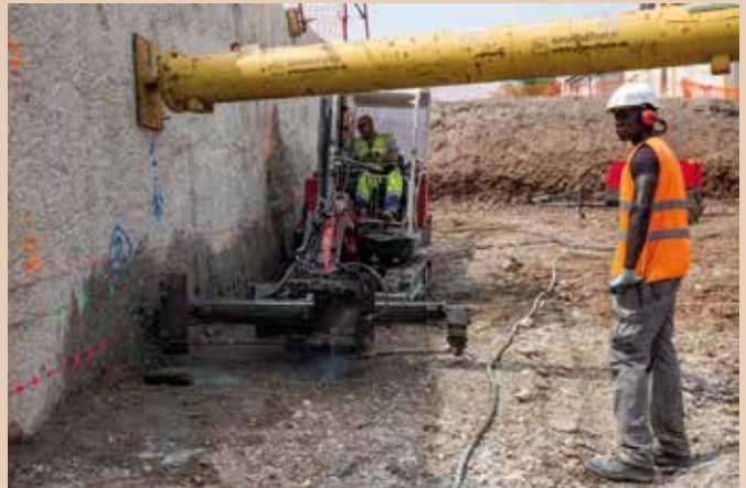
Après soutènement les parois moulées sont percées pour sceller les barres d'ancrage du radier.
