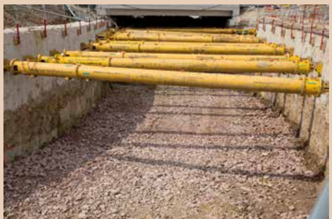
Après l'installation des butons, place à la couche de consolidation. (Photos Passion photo club).
