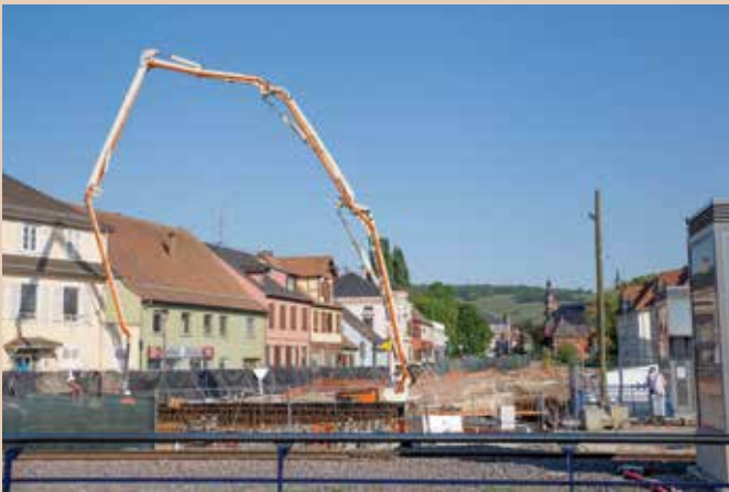
Vue d'ensemble côté Nord, avec l'église des Jésuites en arrière plan.
