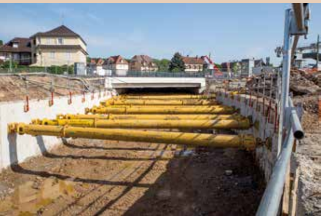
Des butons, structures métalliques de forme cylindrique, ont tout d'abord été installés pour empêcher la déformation des parois moulées lors des travaux de terrassement.
