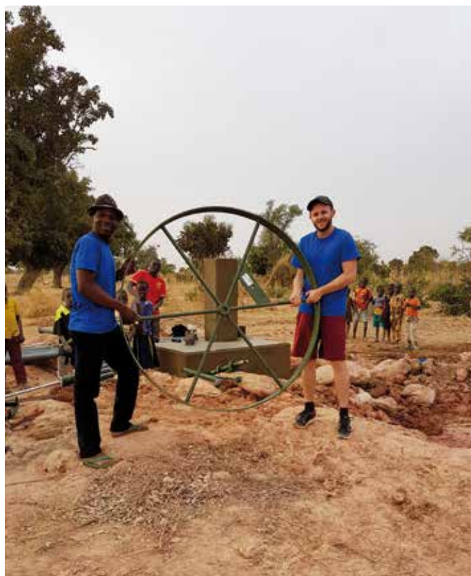
Avec le vice-président d'Humaniburkina, Rimyalego Kiebre, Stéphane Lachambre a réalisé trois nouveaux forages en décembre 2017. Pouvant aller jusqu'à une profondeur de 55 m, ils sont équipés d'un système de pompe Volanta et leur débit varie de 1 à 4,5 m 3 /h.
