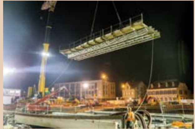
Les travaux de ripage ont nécessité la mise en place d'une grue de 420 tonnes pour assurer la dépose des tabliers provisoires. Les travaux se sont concentrés sur les voies A et B du 2 au 5 mars puis sur la voie C du 9 au 12 mars.
