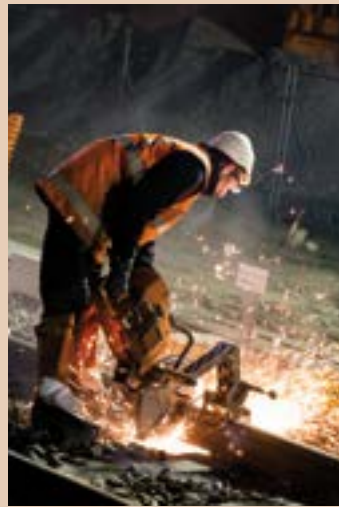
Coupe d'un rail sur l'une des voies ferrées.
