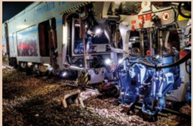
Parmi ces différentes opérations spectaculaires figurait le travail de la bourreuse. Cet engin est utilisé pour positionner au millimètre près la voie ferrée tant sur le plan vertical que sur le plan horizontal. Il compacte le ballast sous les traverses pour stabiliser la voie. Ces opérations se déroulent en plusieurs étapes successives et sont indispensables pour restituer une voie apte aux circulations ferroviaires en toute sécurité.
