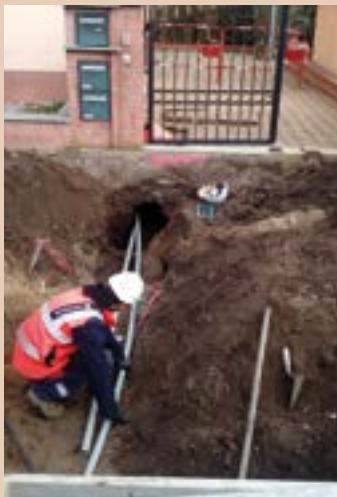
Les réseaux secs (téléphonie et haut débit) ont été enfouis
