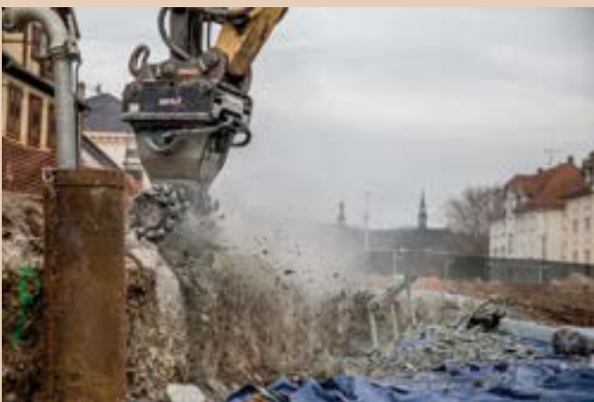
Après les travaux de ripage, place au recépage des parois moulées côté Nord (Photos Passion photo club).
