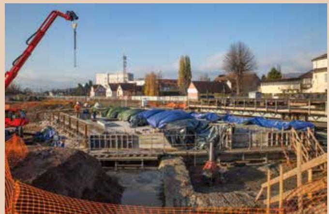
Après le coulage de parois moulées, place à la fabrication des tabliers définitifs. Deux sont en cours de construction côté Sud. Les tabliers définitifs du pont-rail seront substitués aux tabliers provisoires en mars 2018.
