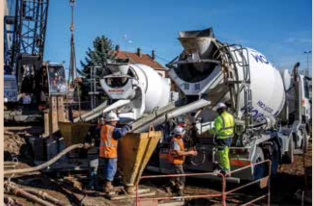
Les travaux spectaculaires de pose de parois moulées se sont terminés fin novembre. La benne hydraulique utilisée pour excaver, les tubes plongeurs de bétonnage qui descendaient jusqu'au fond du panneau et les silos bleus remplis de bentonite ont désormais déserté le paysage de la gare (Photos Passion photo club).
