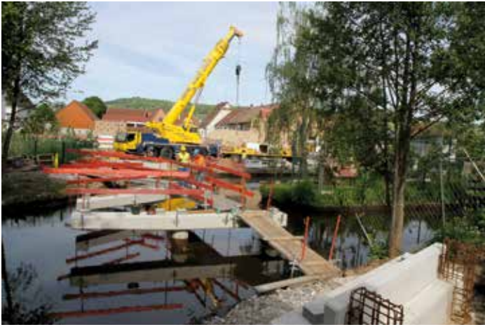
La nouvelle passerelle est située entre le futur square et le gymnase pour accueillir les flux cyclistes et piétons.
