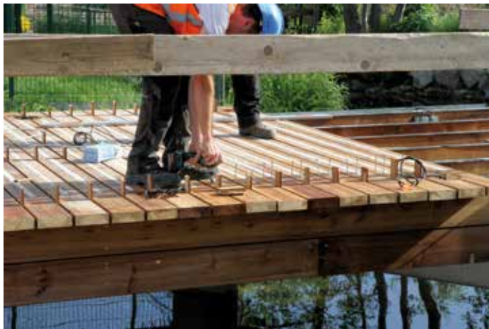
Après l'implantation des structures métalliques, l'entreprise Saert de Benfeld a procédé au platelage.
