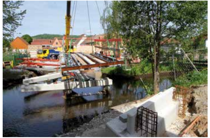
Ce sont les établissements Barthel de Wissembourg qui se sont occupés de l'armature métallique de la passerelle.
