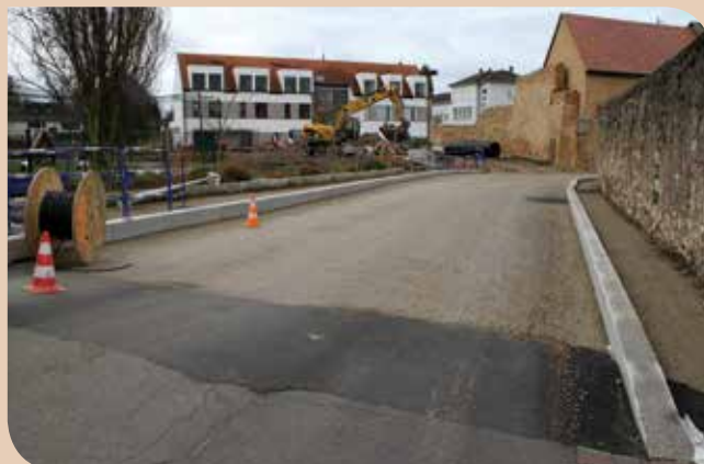
La sous-couche a été mise en place et le pavage de la chaussée s'effectuera durant les vacances scolaires de printemps.
