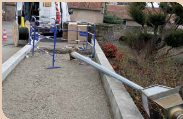
L'entreprise Sogeca s'occupe du renouvellement des réseaux d'éclairage public.
