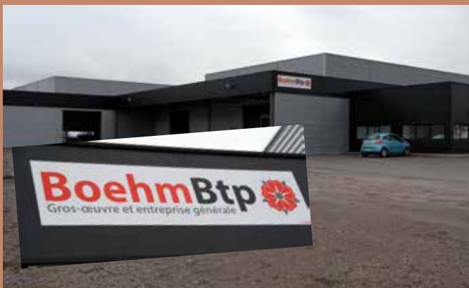
Les travaux d'extension de Boehm BTP sont en cours d'achèvement. Le logo historique a été modernisé pour se rapprocher de celui du groupe.
