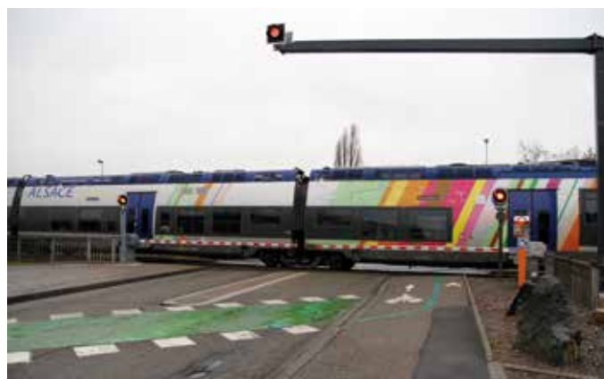
Le passage à niveau n°21 est situé sur la ligne Strasbourg -Saint-Dié. Le feu sur potence améliore sa visibilité.
