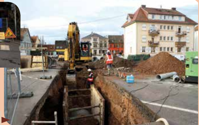
Route de Dachstein, des tranchées profondes ont été creusées pour la rénovation des réseaux d'assainissement notamment.
