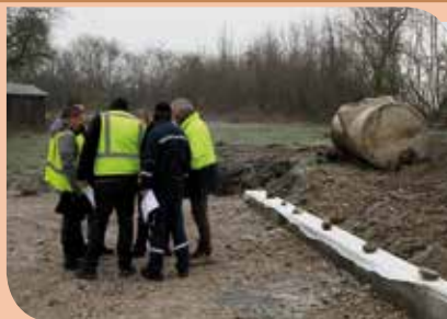
Rue Julien, les longrines en béton ont d'ores et déjà été posées. L'entreprise Sogeca entreprend d'installer les réseaux.
