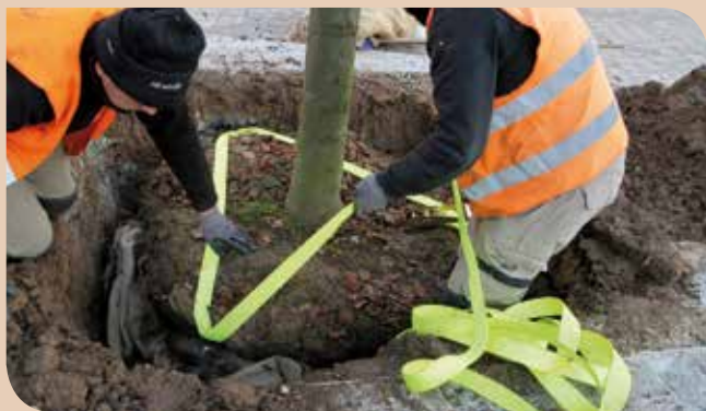
Les professionnels ont opté pour une plantation avec ancrage souterrain : trois pieux ont été solidement fixés avec des sangles d'arrimage.
