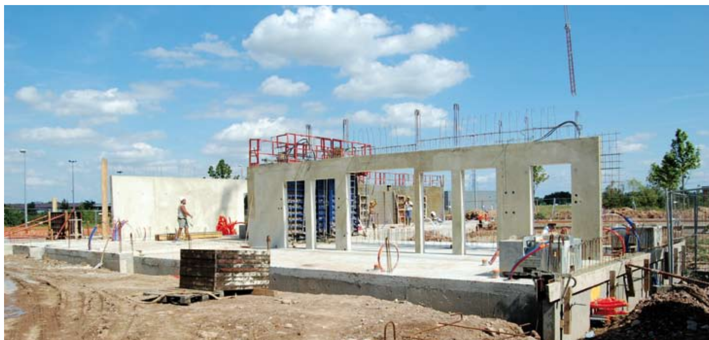
Les locaux de services se trouvent à proximité de l'entrée située rue d'Altorf. L'accès à la caserne est contrôlé par une barrière levante sous la commande du planton. 12 places de parking visiteurs, dont une pour personnes à mobilité réduite, sont aménagées le long de la rue d'Altorf.
