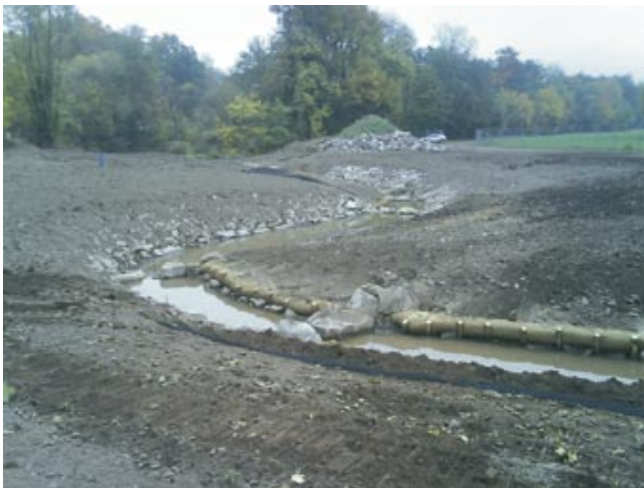
Ouvrage en phase d'achèvement.
