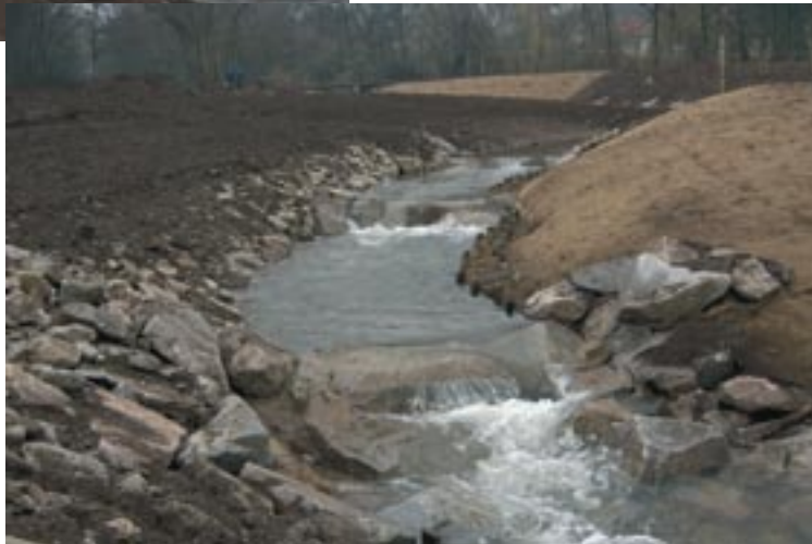
Vue sur la passe à poissons.
