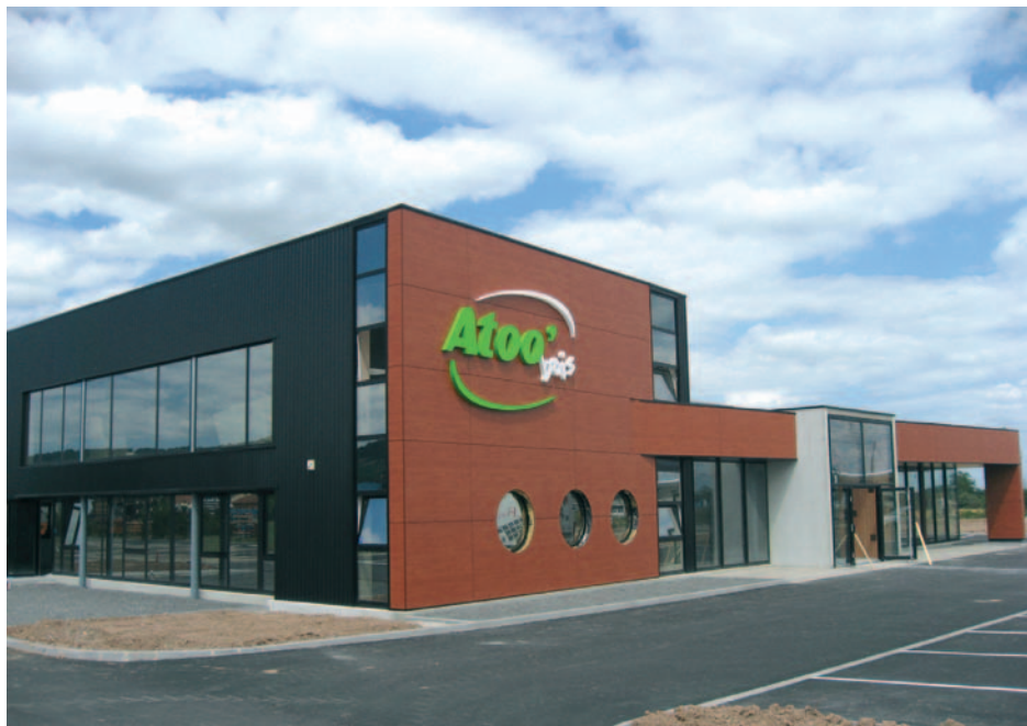
Le nouveau bâtiment d'Atoo Bois, 19 route Ecospace.
