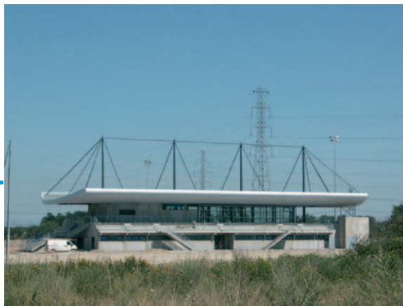
Chantier du Stadium.
