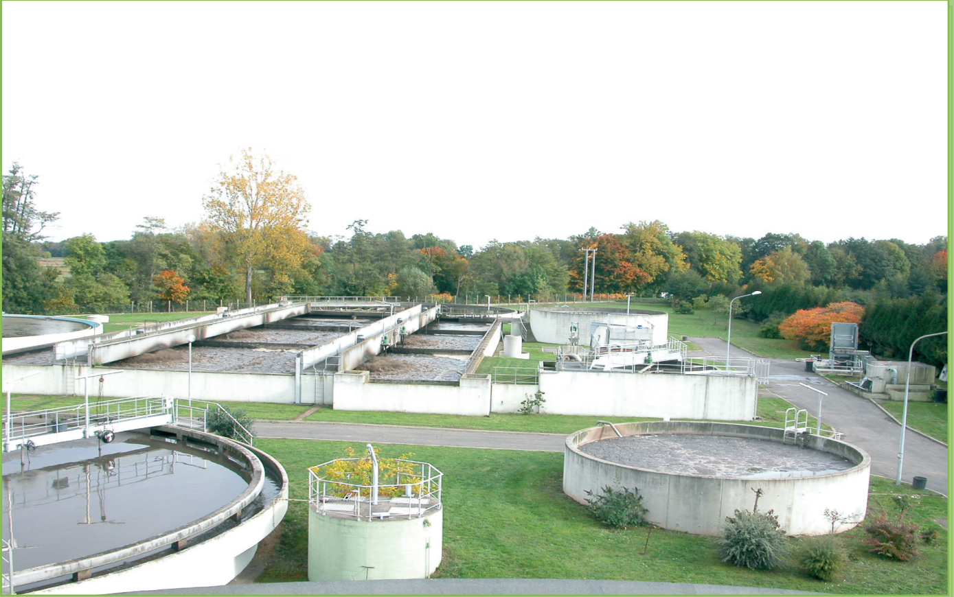
Vue générale de la station d'épuration de Molsheim.
