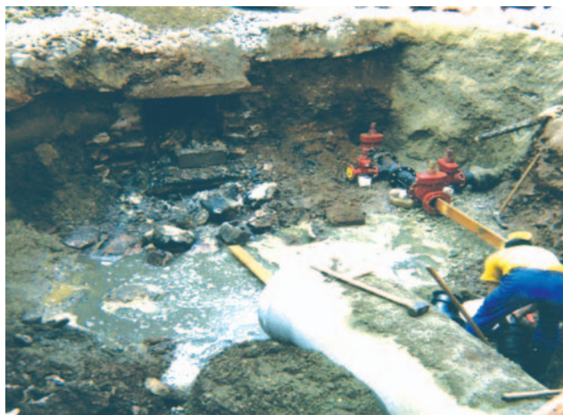
Découverte de conduites maçonnées en pierre de taille lors de travaux de rénovation rue de Strasbourg.
