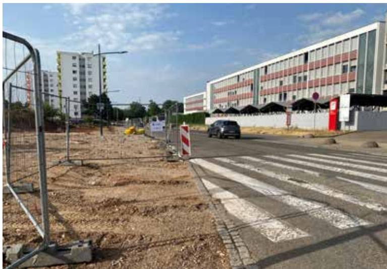
4. Les travaux du quartier Henri-Meck ont démarré le 19 juin.
