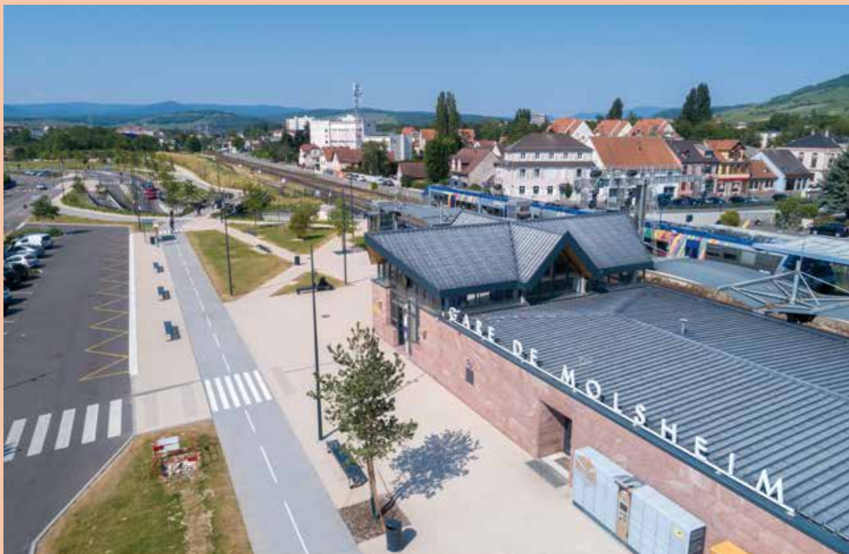
Avec l'installation de la passerelle, c'est l'entrée Sud de la Ville qui termine sa métamorphose (Photo Drone sessions).
