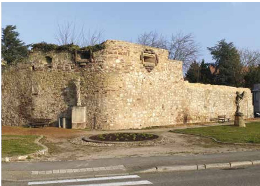
12. Un premier tronçon a été restauré permettant de dévoiler l'emplacement de la tour de la Poudrière.
