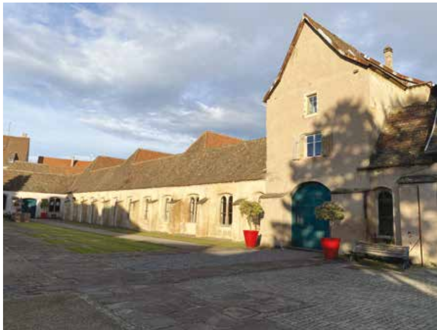
8. La réhabilitation de la bibliothèque de la Chartreuse est soumise à la validation des services de l'État.
