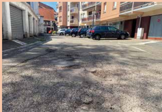
Les travaux d'eau et d'assainissement sont entrepris par l'intercommunalité rue des Capucins à partir du 11 juillet et seront suivis par un renouvellement de la chaussée.
