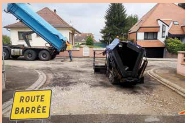
Outre le renouvellement du réseau Haute tension afin de sécuriser et d'améliorer la qualité de fourniture électrique, la Ville a également repris les enrobés rue du Kreuzel.
