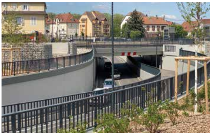
Prochaine étape : la pose de la passerelle permettant la jonction des deux tronçons de pistes cyclables.
