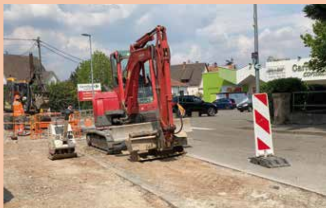
Les travaux de réseaux d'eau potable sont quasiment terminés rue Henri Meck. Il reste à raccorder la conduite à la cité éponyme. Les travaux sont prévus du 1 er au 5 août et nécessiteront la fermeture de la chaussée.
