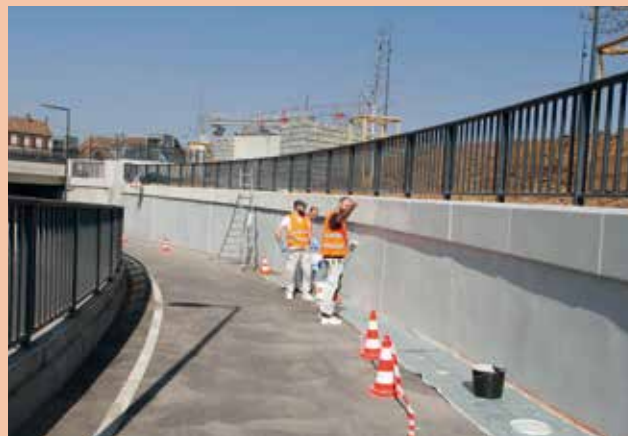
Les travaux d'embellissement de la trémie ont commencé. Ils nécessiteront une fermeture du tunnel du lundi 11 au jeudi 14 avril puis du mardi 19 au vendredi 22 avril.
